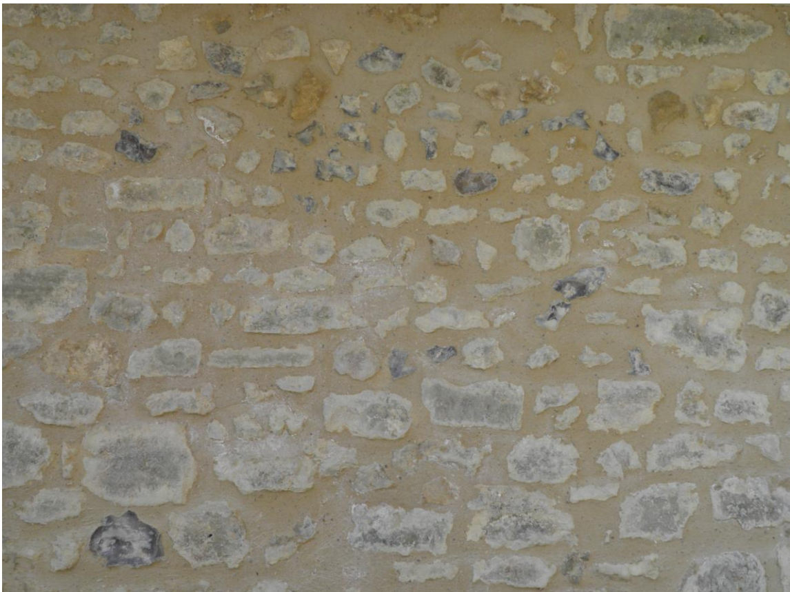
Parement du château restauré, composé de moellons plus ou moins taillés.
