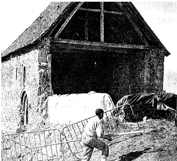
Etant donné de délabrement avancé de l'édifice, bon nombre d'éléments en bois sont remplacés, la charpente est démontée.
